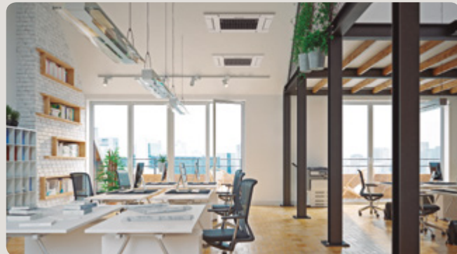
Für eine optimale Luftverteilung: Kassettengeräte im Rastermaß
