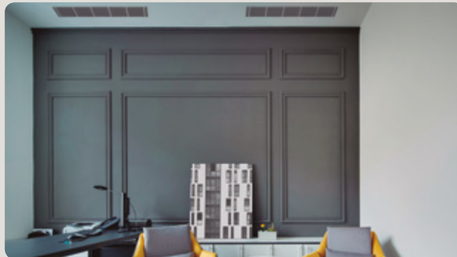
Nahezu unsichtbar: Kanalgerät mit Luftauslässen
